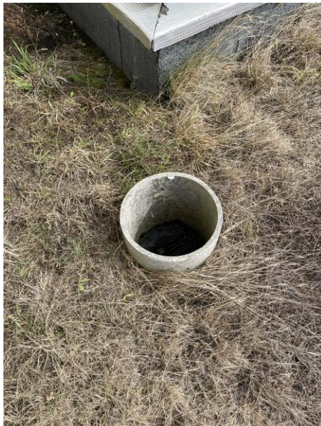
Figure n° 02 _ exemple de regard de visite en fibro ciment
