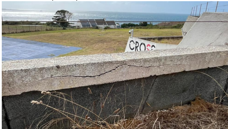
Figure n° 08 _ Exemple fissure à traiter
